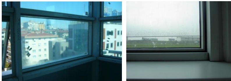
Şekil 2.1 Cam ünitesinde yoğuşma görülmesi
