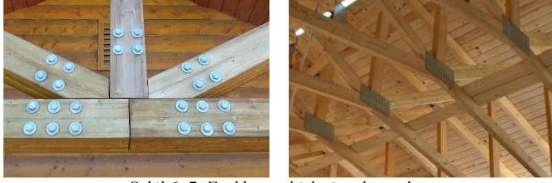
Şekil 6. 7. Farklı çatı birleşim elemanları
