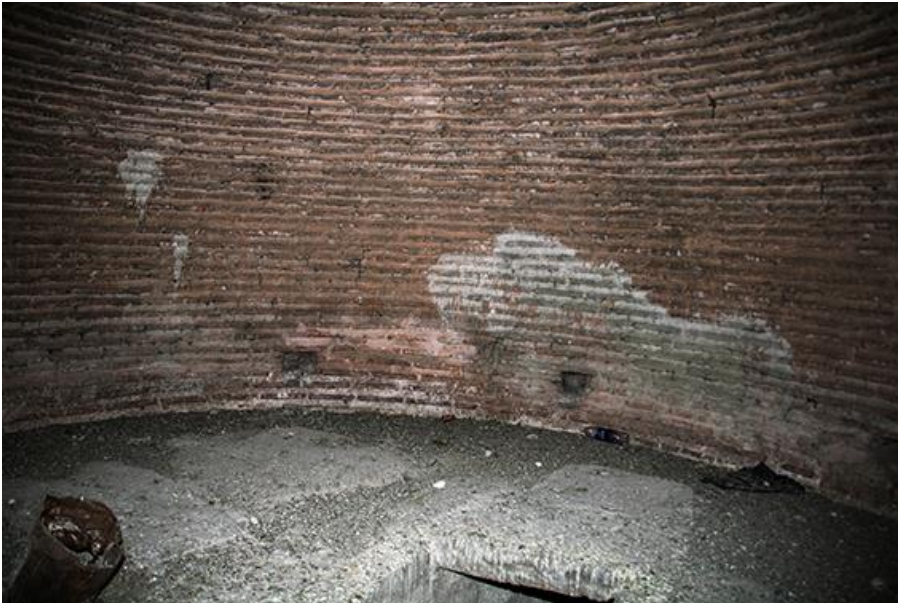
Fotoğraf 2- Süleymaniye Camii ağırlık kulesi kubbesi onarımında altta horasan harcı, arada toprak
