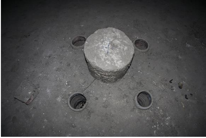
Fotoğraf 3- Kanuni Sultan Süleyman Türbesi iki kubbe arasında iç kubbe kilit taşı ve sebular
