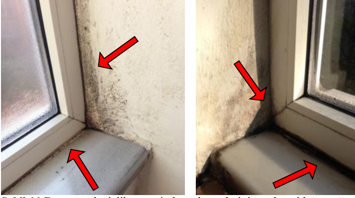
Şekil 11 Duvar ve denizlik yüzeyinde ısı köprülerinin neden olduğu yoğunlaşma, terleme, küflenmeler (Fotoğraf: S. Ekinci)
