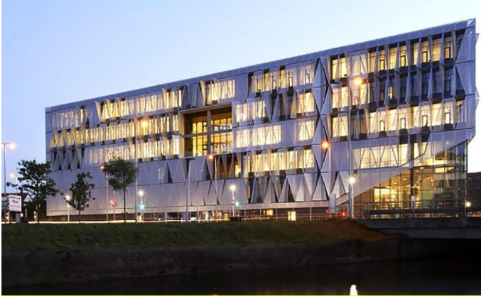
Şekil 2. Binanın dıştan görünümü [7]
