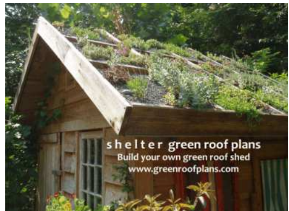
Şekil-6: Kırma çatıda ekstansif bitkilendirme
