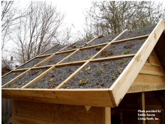
Şekil-5: Kırma çatıda çapraz tahtaların yerleşimi bitkilendirme
