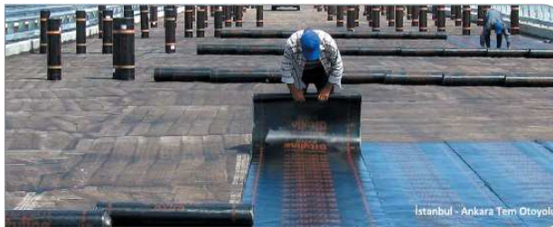
Şekil-3: Yalıtım membranı rulolarının yerleştirilmesi (8).
