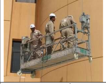
Fotoğraf 3. Cephe İşlerinde Hareketli İskele [20]
