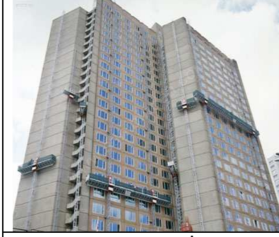
Fotoğraf 1. Cephe İşlerinde Hareketli İskele [18]
