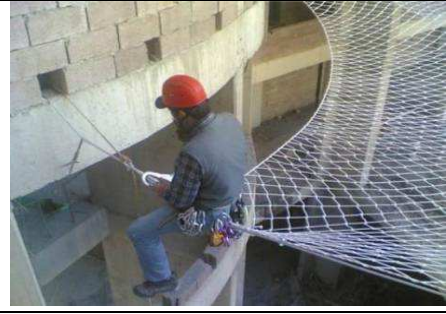
Fotoğraf 5. Cephe İşlerinde KKD Kullanımı [22]
