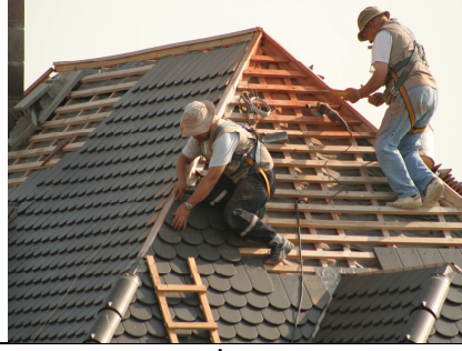
Fotoğraf 9. Çatı İşlerinde KKD Kullanımı [26]
