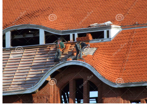
Fotoğraf 11. Çatı İşlerinde KKD Kullanımı [28]
