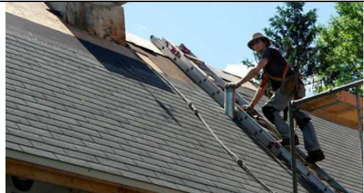
Fotoğraf 7. Çatı İşlerinde KKD Kullanımı [24]
