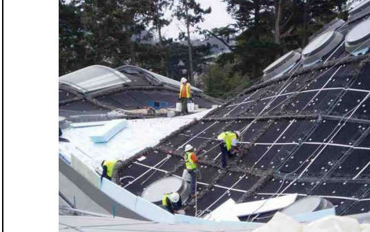
Fotoğraf 10. Çatı İşlerinde KKD Kullanımı [27]
