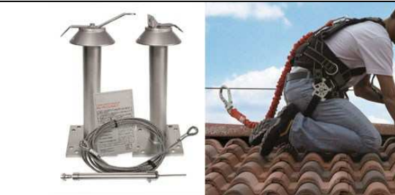
Fotoğraf 6. Çatı İşlerinde KKD Kullanımı [23]
