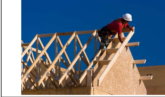
Fotoğraf 8. Çatı İşlerinde KKD Kullanımı [25]
