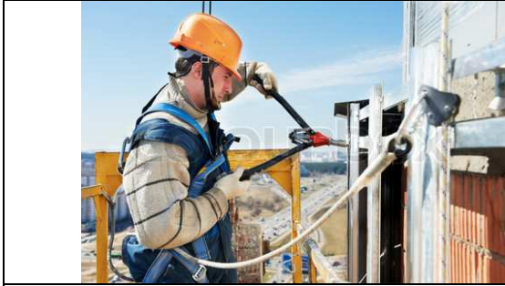
Fotoğraf 4. Cephe İşlerinde KKD Kullanımı [21]
