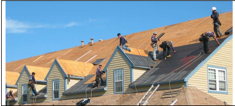
Fotoğraf 12. Çatı İşlerinde KKD Kullanımı [29]
