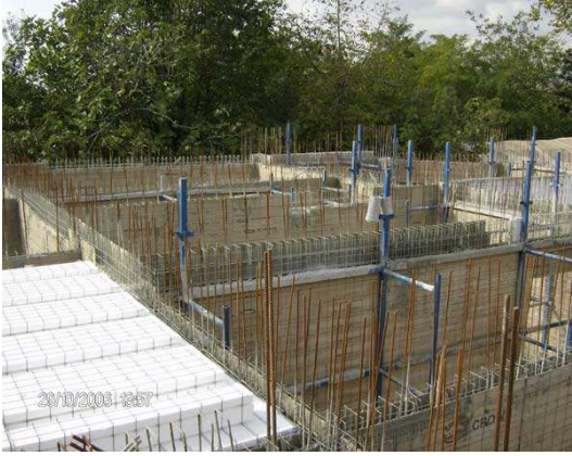
Şekil 5 Döşeme panellerinin hazırlanması [5]
