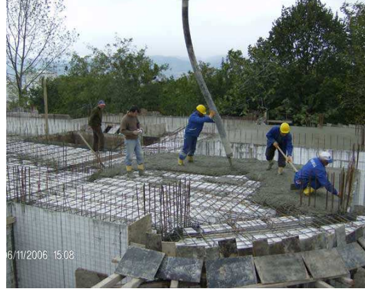
Şekil 6. Döşemenin betonlanması [5]
