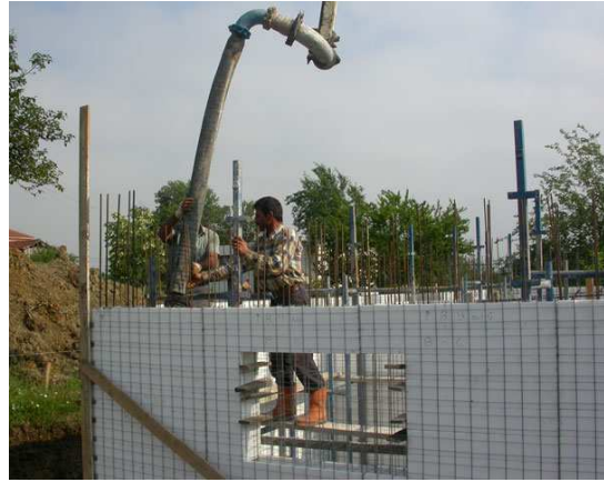
Şekil 2. Duvar panellerinin yerleştirilmesi [5] Şekil 3. Duvarların betonlanması [5]
