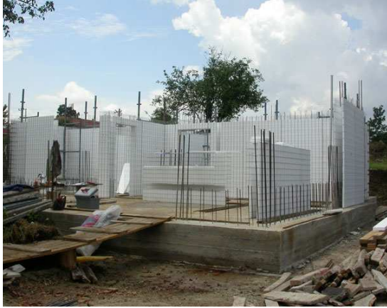
Şekil 2. Duvar panellerinin yerleştirilmesi [5] Şekil 3. Duvarların betonlanması [5]
