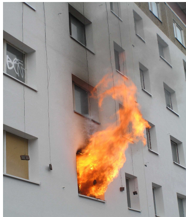
Şekil 2a ve 2b. Alev ve dumanın mantolama cephe boyunca hareketi [15]
