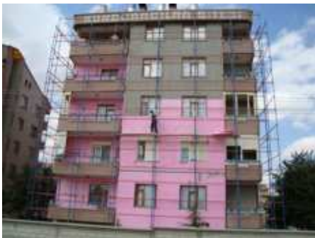
Şekil 5. Sonradan yapılan ısı yalıtım uygulaması
