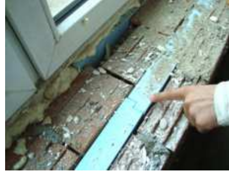
Şekil 8. Uygulamanın yakından görünüşü
