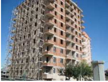
Şekil 1. Isı yalıtımsız cephe uygulaması
