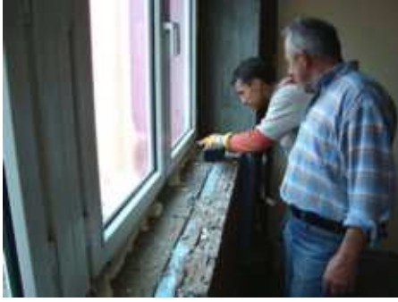
Şekil 7. Sandviç duvar uygulaması
