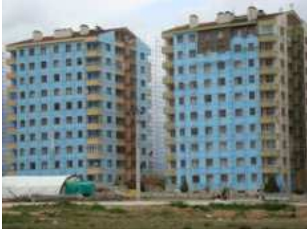
Şekil 3. Cepheye ısı yalıtım uygulaması
