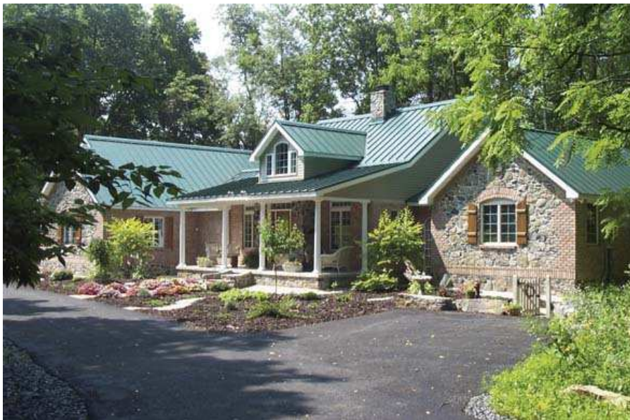
Şekil 4. Az katlı yapılarda çatı mimarinin en temel öğesidir
