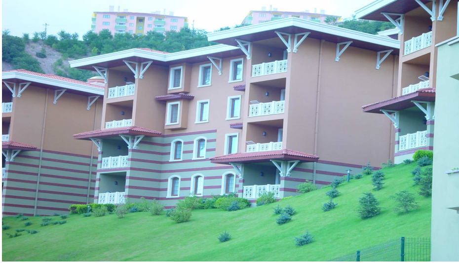
Şekil 3 Apartman yapılarında çatı saçak ve kornişleri mimariye katkı yapabilir
