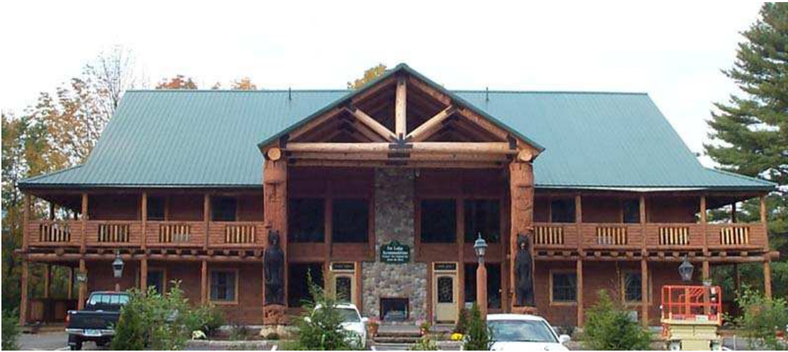
Şekil 5 Çatının yapı ve çevre ile uyumu
