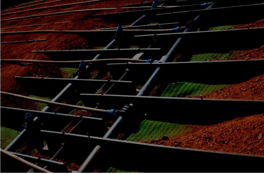
Resim-8 Su Tesisatı
