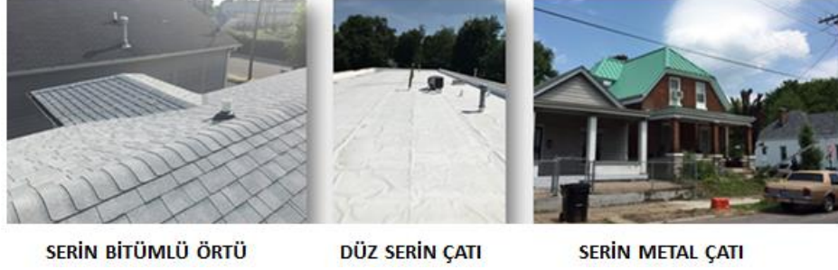
Şekil 4.4. Serin Bitümlü Örtü, Düz Serin Çatı, Serin Metal Çatı Örnekleri.
