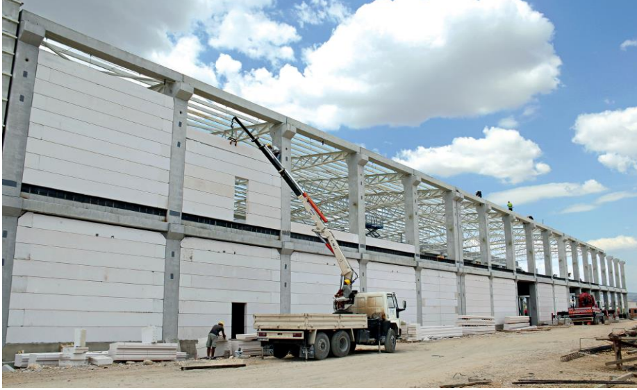
Resim 4. Gazbeton cephe elemanlarının montajı
