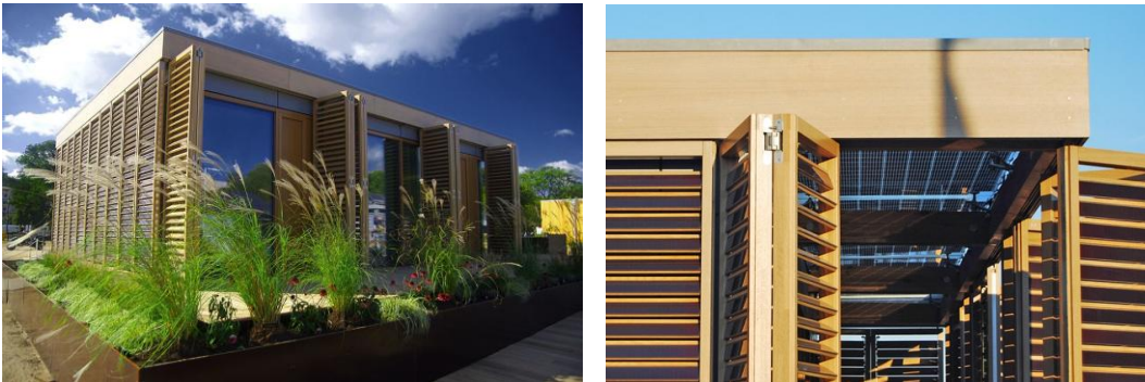
Fotoğraf 4. Cephe panjur sisteminin fotovoltaik panellerle desteklenmesi [10]
