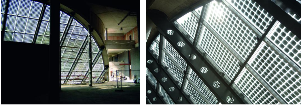
Fotoğraf 2. The OLV Hospital binasının güney cephesinde fotovoltaik panel kullanımı [7]
