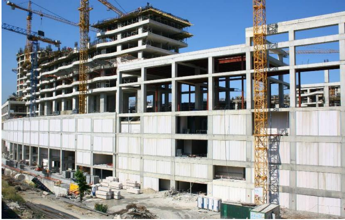
Fotoğraf 5: Gazbeton donatılı duvar elemanlarının düşey uygulanması
