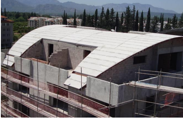
Fotoğraf 7: Gazbeton donatılı çatı elemanları ile tonoz çatı oluşturulması
