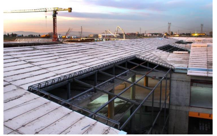
Fotoğraf 6: Gazbeton donatılı çatı elemanları ile eğimli çatı oluşturulması
