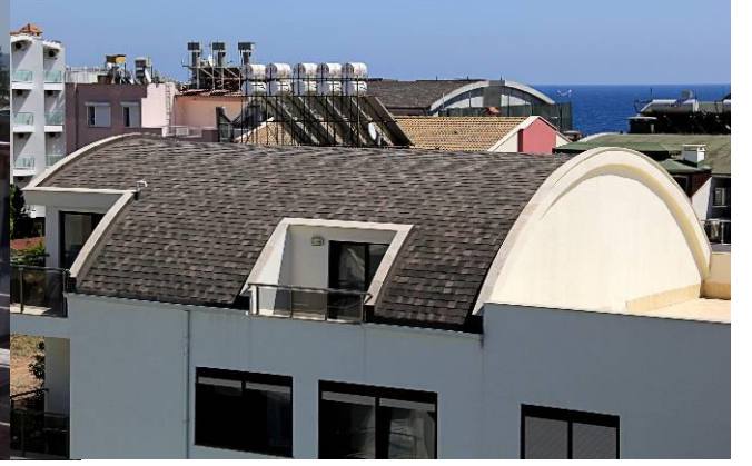
Fotoğraf 8: Gazbeton donatılı çatı elemanlarının üzerine çeşitli çatı kaplama malzemelerinin uygulanması
