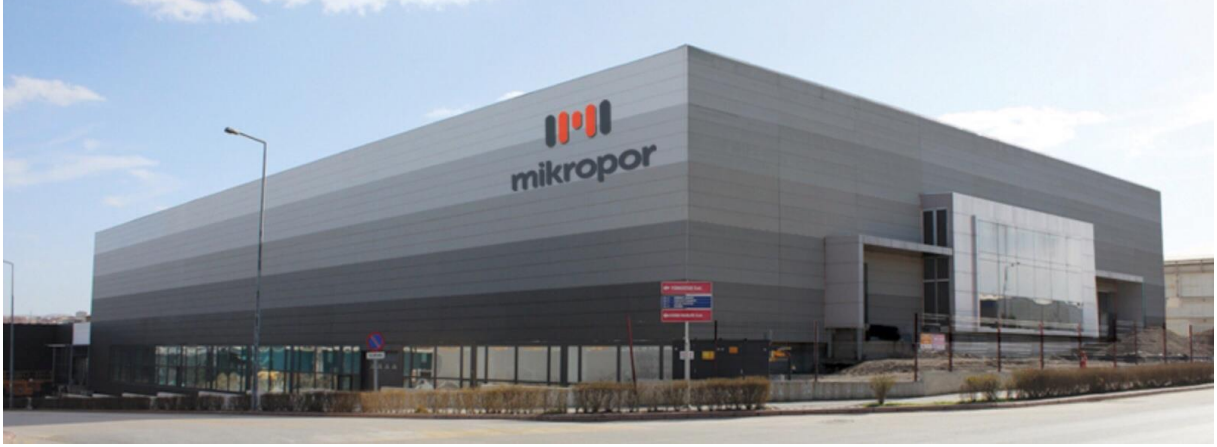
Fotoğraf 4: Gazbeton donatılı duvar elemanlarının yatay uygulanması
