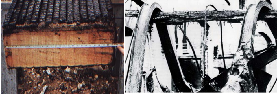
Resim 1. Dış tabakalarda kömürleşme (Sol), Ahşabın eriyen metal kirişleri taşıması (Sağ)
