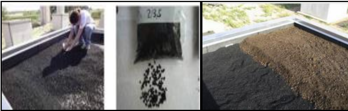
Şekil 7: Atık lastiklerden elde edilmiş kauçuk agrega parçacıkları ve bitkilendirilmiş çatı sistemi [29]
