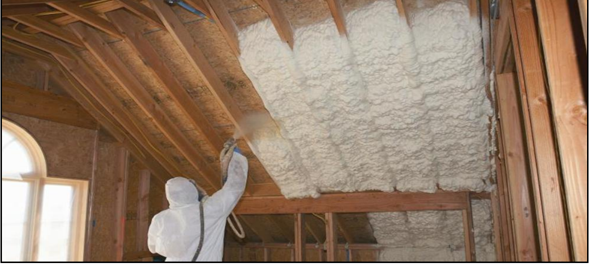
Şekil 3: Çatıda yalıtım amacıyla yapılan poliüretan spreyc köpük uygulaması [22]
