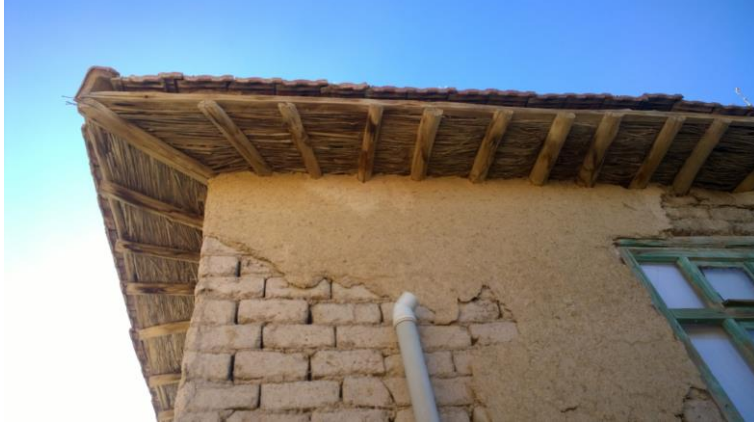
Şekil 6. Konya, Tuzlukçu, Erdoğan. Dökülmüş çamur sıvası. Kamış serilerek toprakla örtüldükten sonra eğim kazandırılarak kiremit kaplanmış çatı örtüsü. (Duran,S., 2015)
