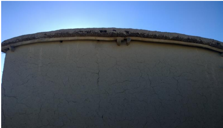
Şekil 1. Konya, Tuzlukçu, Erdoğdu. İki tarafa meyillendirilmiş düz dam örneği. ( Duran,S., 2015)
