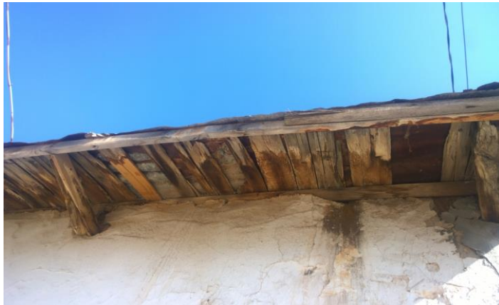
Şekil 5. . Menderes, İzmir. Kerpiç ev üzeri Oluklu levhayla kaplanmış örtü. (Duran,S.,2015)
