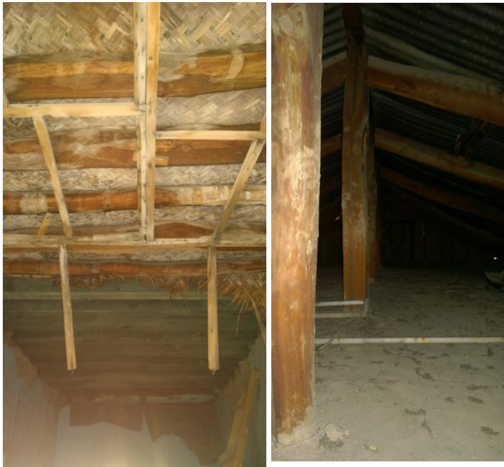
Şekil 4. Çatı döşemesi kaplama sistemi
