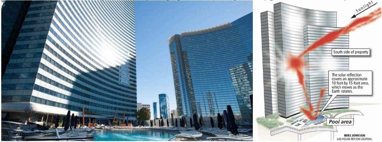
Resim 2: Vdara Hotel'in cephesindeki içbükey ayna etkisi ve cephenin ışığı odaklama davranışı [12]
