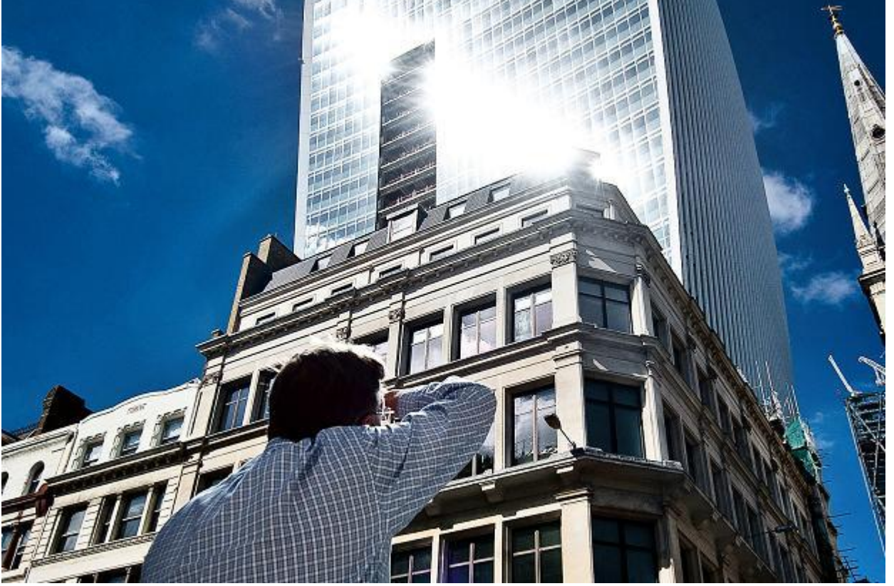
Resim 3: Walkie Talkie Tower binasının cephesinin oluşturduğu yansımaya ve göz kamaşması.
