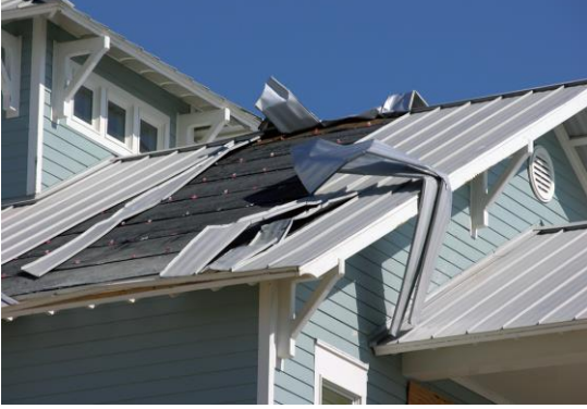
Şekil 4: ABD'deki bir kenetli metal kaplamada kuvvetli rüzgar kaynaklı oluşmuş hasar [10]
