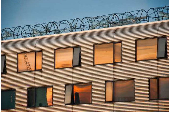
Şekil 6. Metal panel kaplama cepheden görünüm [8]
