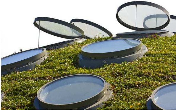
Şekil 5. Yapı çatısında bulunan açılabilir ışıklıklar[7]
