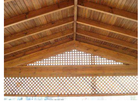
Şekil 9. Ahşap taşıyıcı sistemli beşik çatı.
