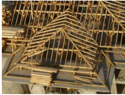
Şekil 10, 11. Ahşap ve çelik taşıyıcılı çatılarda aşık ve merteklerin ters doğrultuda konumlanması.
