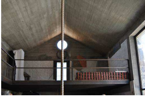
Şekil 7. Betonarme taşıyıcı sistemli beşik çatı.
