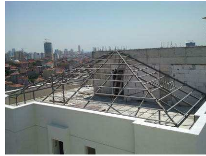
Şekil 10, 11. Ahşap ve çelik taşıyıcılı çatılarda aşık ve merteklerin ters doğrultuda konumlanması.
