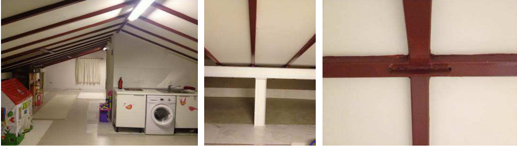
Şekil 15. Yeni çatı bütünsel görünüş
