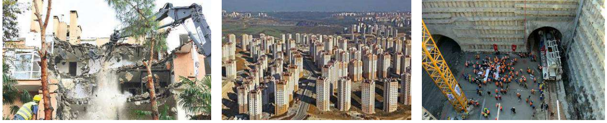
Şekil 1: Erenköy'de yeni konut inşaatı için yıkılan eski konut binası.
