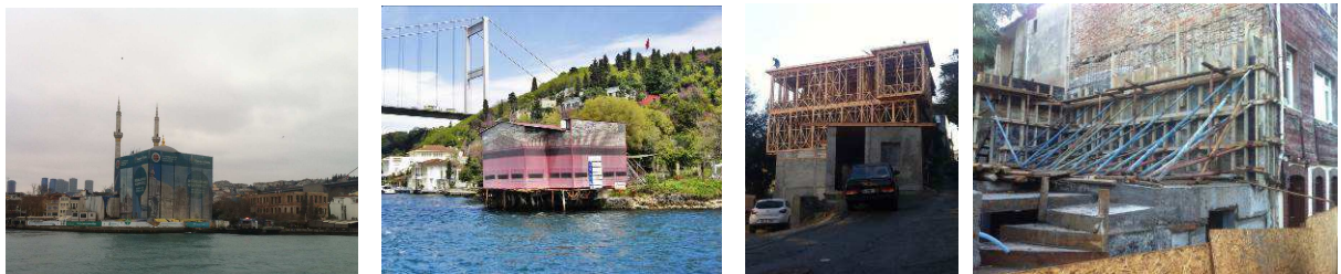
Şekil 1. Ortaköy Camisi Restorasyon Şantiyesi.
