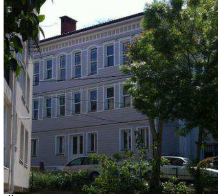
Şekil 14. Örnek binanın batı yönüne bakan ön cephesi.
