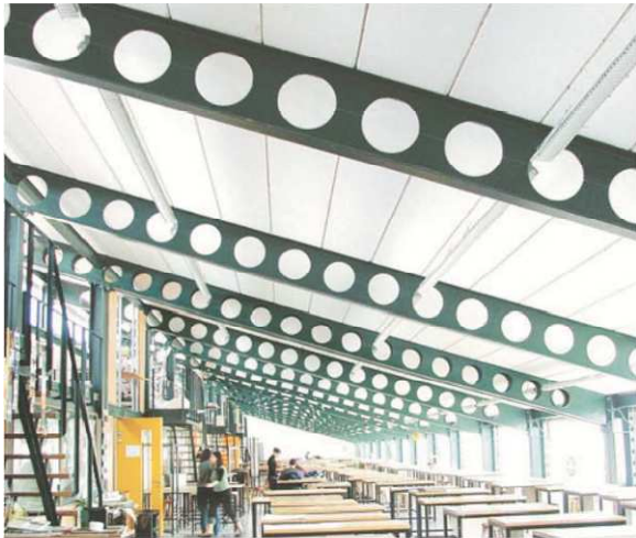
Resim 6: Gazbeton Donatılı Çatı Paneli Örnek Uygulama
