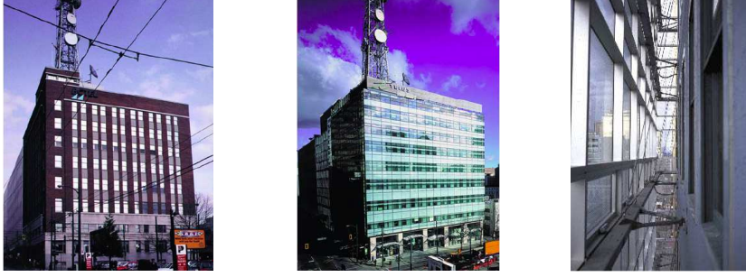
Şekil 2.2 William Farrell Telus Binası, Vancouver, Kanada. Solda binanın yenilemeden önceki görünüşü, ortada yenilemeden sonraki görünüşü, sağda mevcut ve yeni kabuk arasındaki boşluğun görünüş [6][10].
