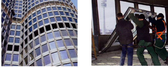
Şekil 2.3 BMW Merkez Binası, Münih, Almanya. Solda cephenin dıştan görünüşü, sağda izolasyonlu ek kabuğun iç mekandan cepheye montajı [7].
