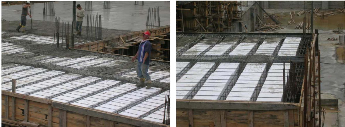
Resim 1.2 EPS dolu bloklarla asmolen döşeme oluşturulması
