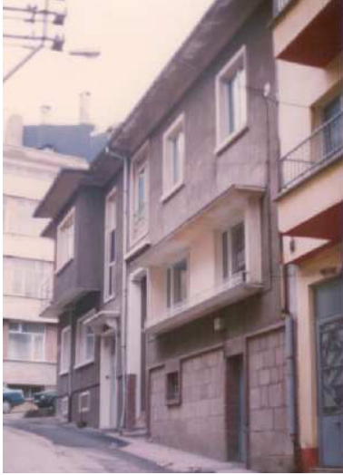
Bahçe Sk no:18 (103 ada-25 parsel) Açık pencere çıkmalı konut örneği
