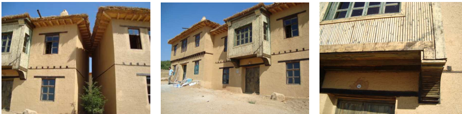
Şekil 6. Cephede saçaklar ve çıkmalar.
