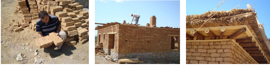
Şekil 1. Kerpiç yapı malzemesinin duvarda uygulanması ve saçak görünüşü
