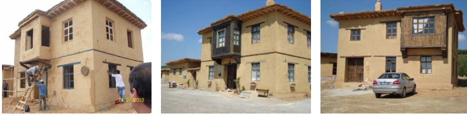
Şekil 5. Dış duvarlarda kerpiç, kapı ve pencere doğramalarında ise ahşap malzeme kullanılmıştır.
