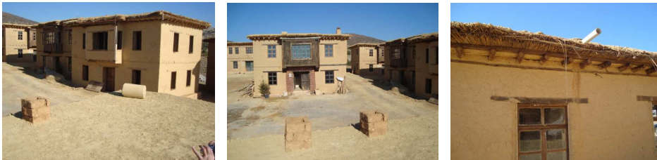
Şekil 8. Toprak dam üzerinde yuvak, kerpiç baca ve toprak damdan suyun uzaklaştırılması.
