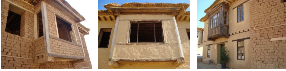
Şekil 4. Kerpiç yapılarda girişler, hatıllar ve dikmelerde ahşap malzemeler kullanılmıştır.
