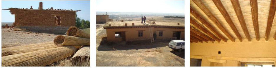
Şekil 2. Çatıda ahşap kirişler üzerine serilen kamyşlar, toprak dam ve tavan görünüşü.
