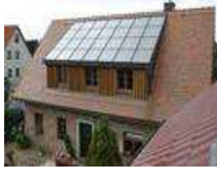
Şekil 18. 1885 yılında yapılmış evin çatısına bütünlüklük kolektör uygulaması[19]
