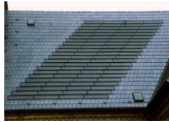
Şekil 14-15. Çatı bütünlüğüne sahip PV renovasyon uygulaması[17]
