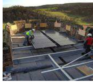
Şekil 12-13. Dunster Kalesi teras çatı bütünlüğüne sahip PV uygulaması[16]
