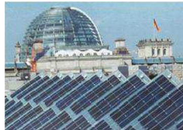
Şekil 10 ve 11. Reichstag Parlamento Binası çatı bütünleşik pv sistem[14]
