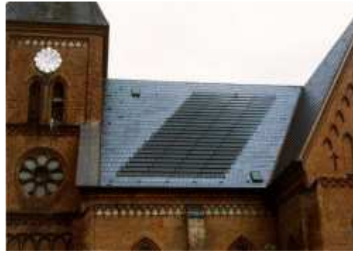
Şekil 14-15. Çatı bütünlüğüne sahip PV renovasyon uygulaması[17]
