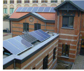
Şekil 18. 1885 yılında yapılmış evin çatısına bütünlüklük kolektör uygulaması[19]
