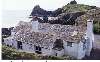
Şekil 16. 2001 yılında yapılan onarım öncesi
