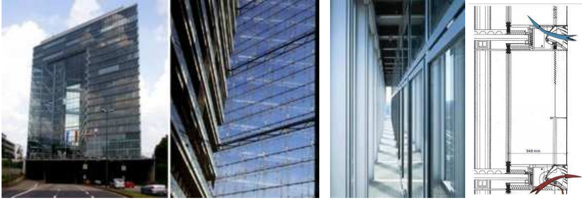
Resim 2. Stadttor Büro Binası'nın Kat Yüksekliğinde Çift Kabuk Cephe Sistemi (17,13)
