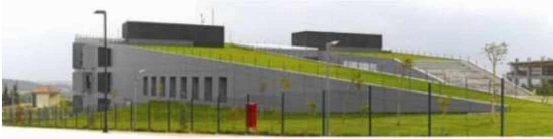
Şekil 9. Türkcell Ar-Ge Binası Yeşil Çatı Görünüşü (8)
