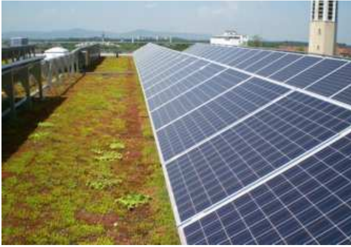
Resim 5: Yeşillendirme ve panel uygulama sonrası
