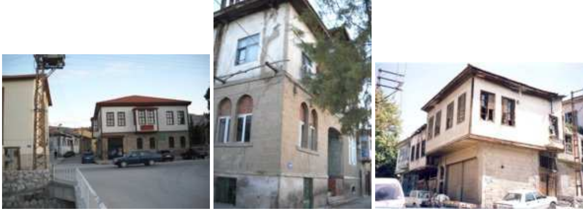
Resim-3: Zemin katı taş duvar, birinci katı karkas arası tuğla ve kerpiç dolgu olan yapı örnekleri (Sıdıka Çetin arşivi)
