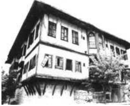
Şekil 8. Kıрма çatılarda saçağın düz olarak devam etmesi, [4]
