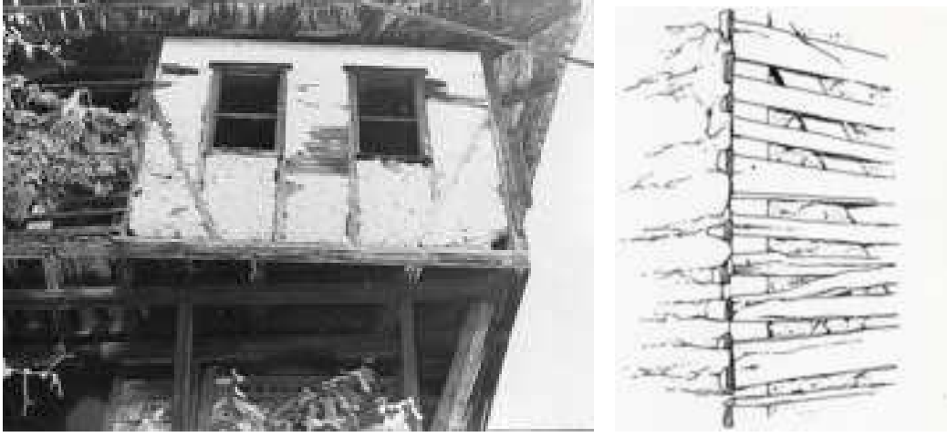
Şekil 3. Hımiş ile oluşturulmuş yapı sistemleri, [4]
