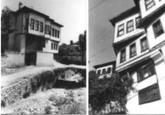
Şekil 4. Plan şemalarından ve topografik yapıdan kaynaklanan çıkma düzenleri, [4]
