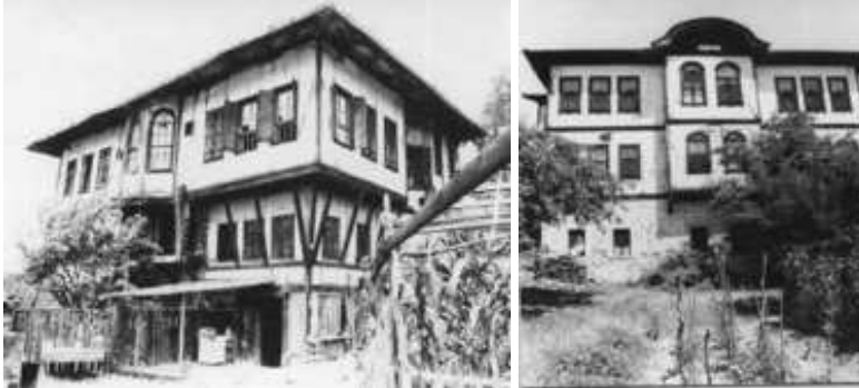
Şekil 5. Plan şemalarının belirleyici olduğu çıkma düzenleri, [5]
