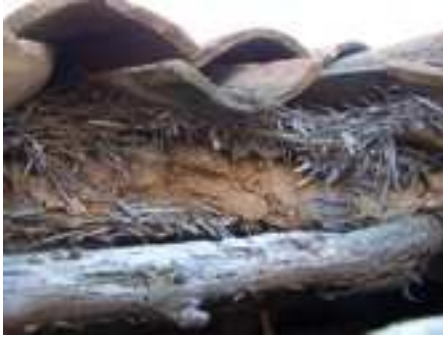
Resim 4.e. Kiremit altında ağaç dalı/ayçiçeği sapı üzerinde sırasıyla çavdar sapı, toprak harç kaplama, çavdar sapı kaplama
