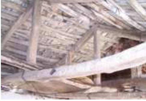
Resim 4.a. Kiremit altı ahşap kaplama
