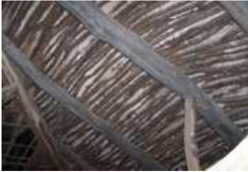
Resim 4.c. Kiremit altında ağaç dalı üzeri toprak harç kaplama
