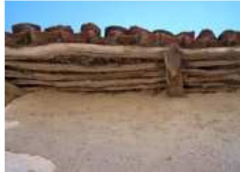
Resim 4.d. Kiremit altında ağaç dalı üzeri eğrelti otu (papra) kaplama
