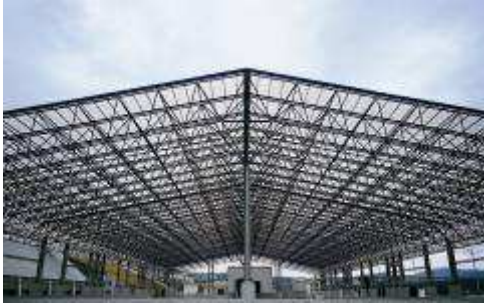
Boraks Kurutma Tesisi -Kütahya
