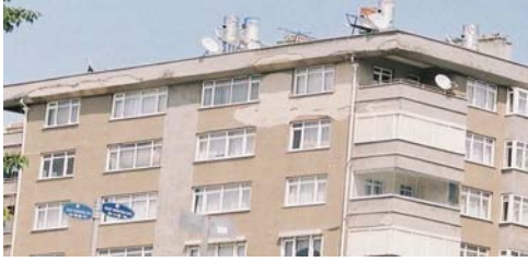
Şekil 1. Saçak parapetlerinde bozulmalar
