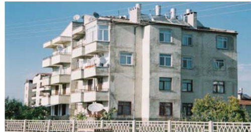
Şekil 4. Pencere ve balkonların durumu
