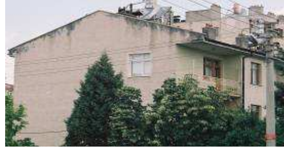
Şekil 17. Parapette harpuştanın sorunu ve bozulma. Şekil 18. Harpuştadaki suyun parapeti bozması
