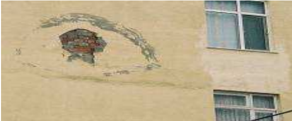
Şekil 15. İç mekanlardan sızan sular sıvayı bozmuştur
