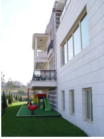
Fotoğraf 13. Ziyafet salonu (Deniz cephesi detayı)
