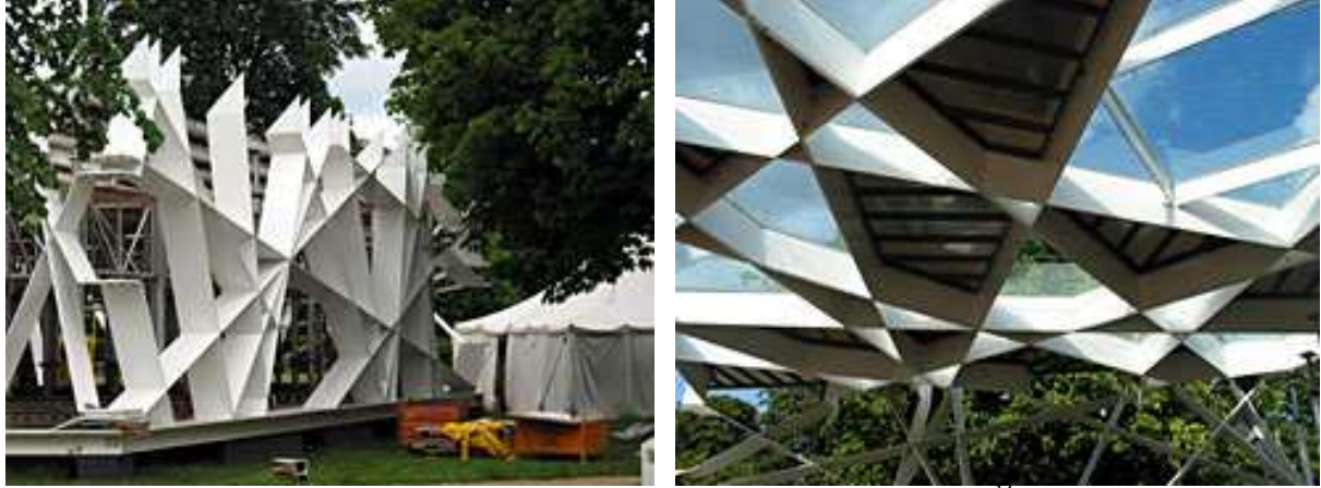
Şekil 9. Pavilion At The Serpentine Gallery - London 2002. Yapım aşamasındayken. 14
