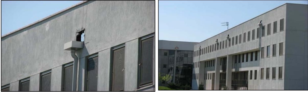
Şekil 6. Yanlış gizli oluk uygulamasına geliştirilen çözüm
