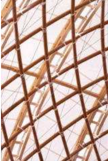
Şekil 9. Japon Pavyonu iç-dış mekanı, kağıt strüktür birleşim detayı
