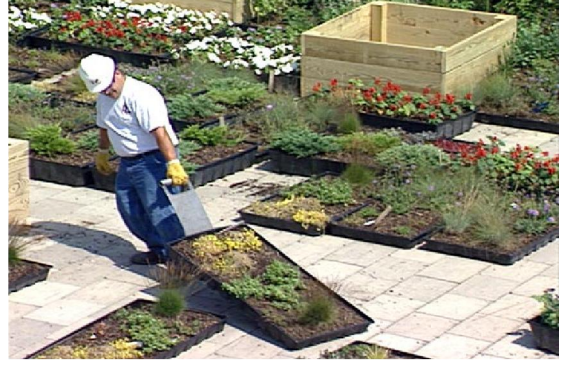
Resim 9. Modüler Elemanlarla Yeşil Çatı Uygulaması
