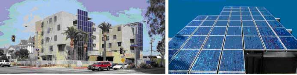
Resim:2: Cephede fotovoltaik pilleri kullanan bir yapı.
