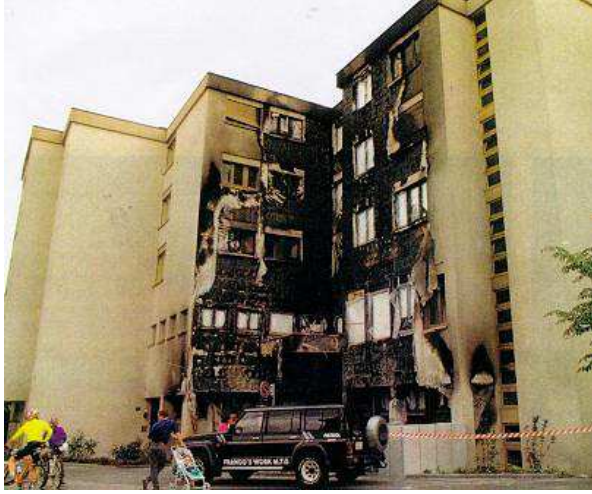
Şekil 4 Apartment Building, Munich, 1996[2], Yanıcı cephe kaplamasının bir çöp varilinden alev alması sonucu cephe yangını oluşmuştur.
