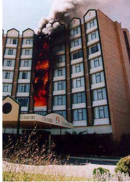
Şekil 5 Motel fire, NSW, Australia 1999[2], Parapetlerde kullanılan PVC malzemenin yangını desteklemesi ile üst katlara yayılan cephe yangını
