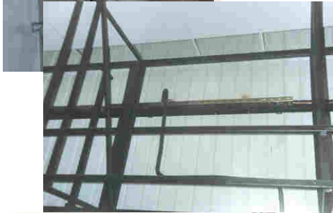
Resim 19. Hatalı örülmüş sonucu panellerle duvar arasında kalan boşluk
