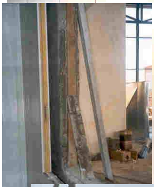
Resim 15. Hatalı yerleştirilmiş sundurma damlalığı
