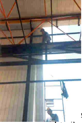
Resim 3. Çatı panelinin yerine sabitlenmesi
