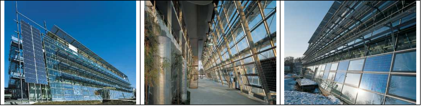
Solar Fabrik Yönetim Binası (4)
