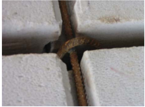
Şekil 11. Plaklar Arası Derzde Donatı Detayı
