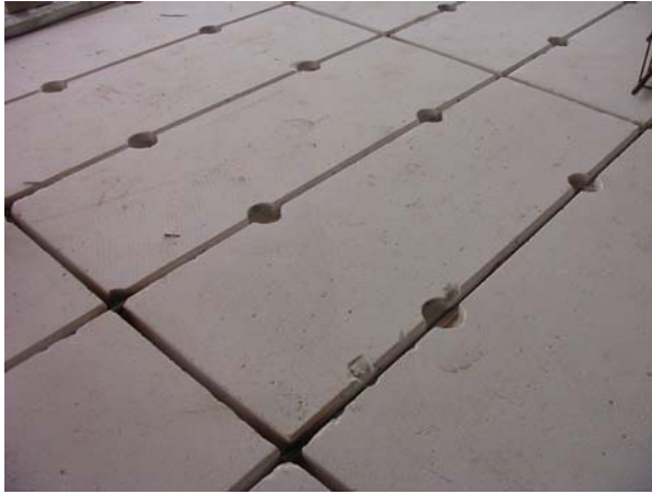
Şekil 10. Kayma Kaması Düzeni
