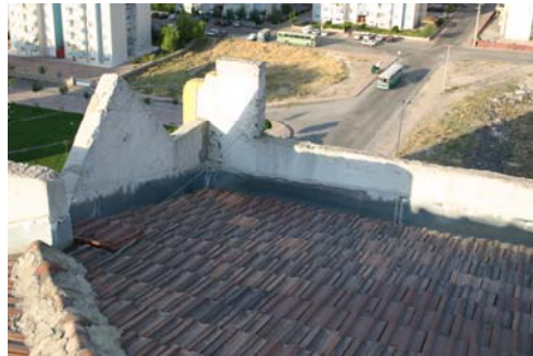
Resim 9. Beyazşehir toplu Konutları'nda gizli çatı ve parapet uygulaması
