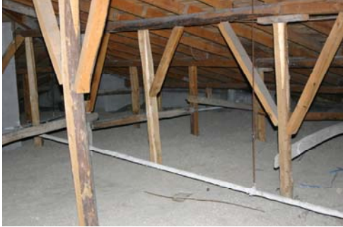
Resim 7. Beyazşehir Toplu Konutları'nda bims ile gerçekleştirilen ısı yalıtımı
