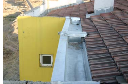
Resim 8. Beyazşehir Toplu Konutları'nda gizli çatı oluk detayı
