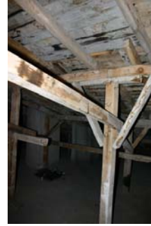
Resim 4. Beyazşehir Toplu Konutları'nda çatı strüktürü
