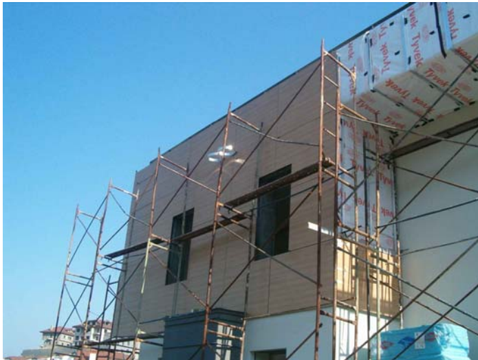
Foto3: Kompakt Laminat Giydirmeye Cephe Sistemi arkasında ısı yalıtımı ve buhar dengeleyici uygulaması (Acarkent Ergun Işıkel Evi).
